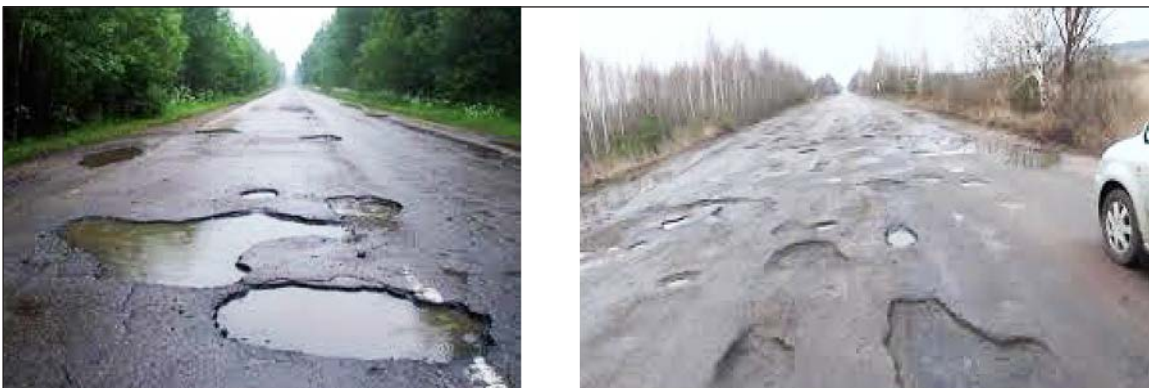
Рис. 2. Ями та вибоїни на дорогах
