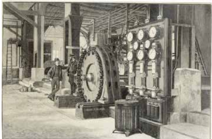
б – Трифазний генератор на ГЕС Лауффен, 1891 р. (P = 230 кВт, n = 150 об/хв, U = 95 В)
