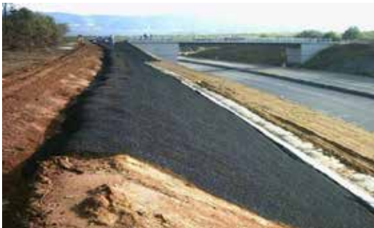
Рис. 2. Укріплення укосів геоматами
