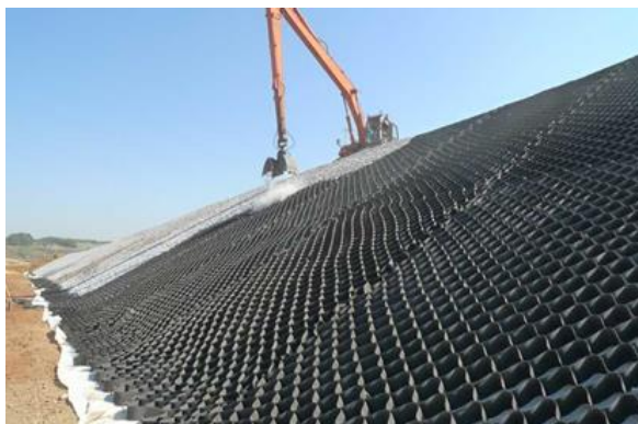
Рис. 1. Укріплення укосів та конусів шляхопроводів георешіткою
