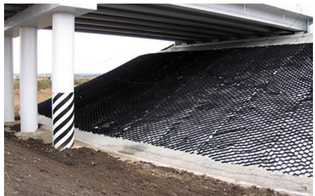
Рис. 1. Укріплення укосів та конусів шляхопроводів георешіткою
