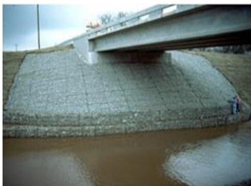
Рис. 4. Укріплення укосів насипів та конусу мостів матрацами Рено
