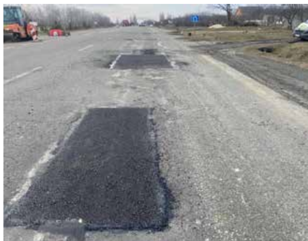
Рис. 2. Загальний вигляд ділянки дороги після проведення ямкового ремонту
