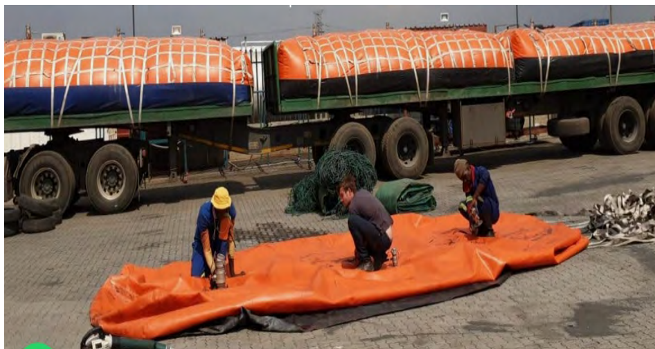
Рис. 4. Підготовка спеціального флексі-танку для транспортування дизельного палива
